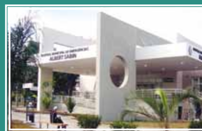
Hospital de Emergências Albert Sabin
