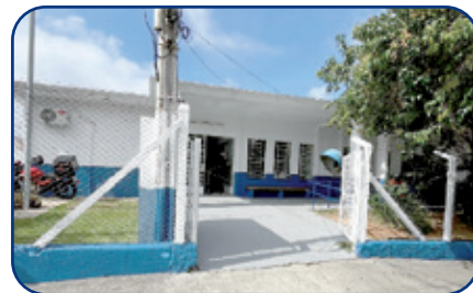
Fachada da UPA Jardim Universo
