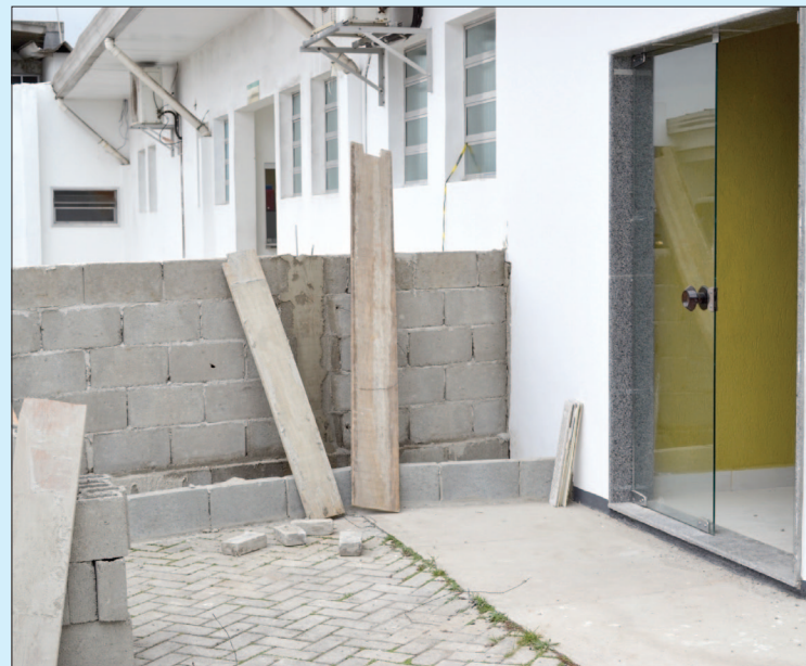
Acima, obras do Ambulatório do HMID; ao lado, encontro de Pet Terapia
