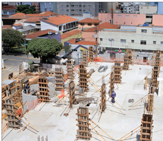
Em São Caetano, hospital em construção no Bairro Santa Paula
