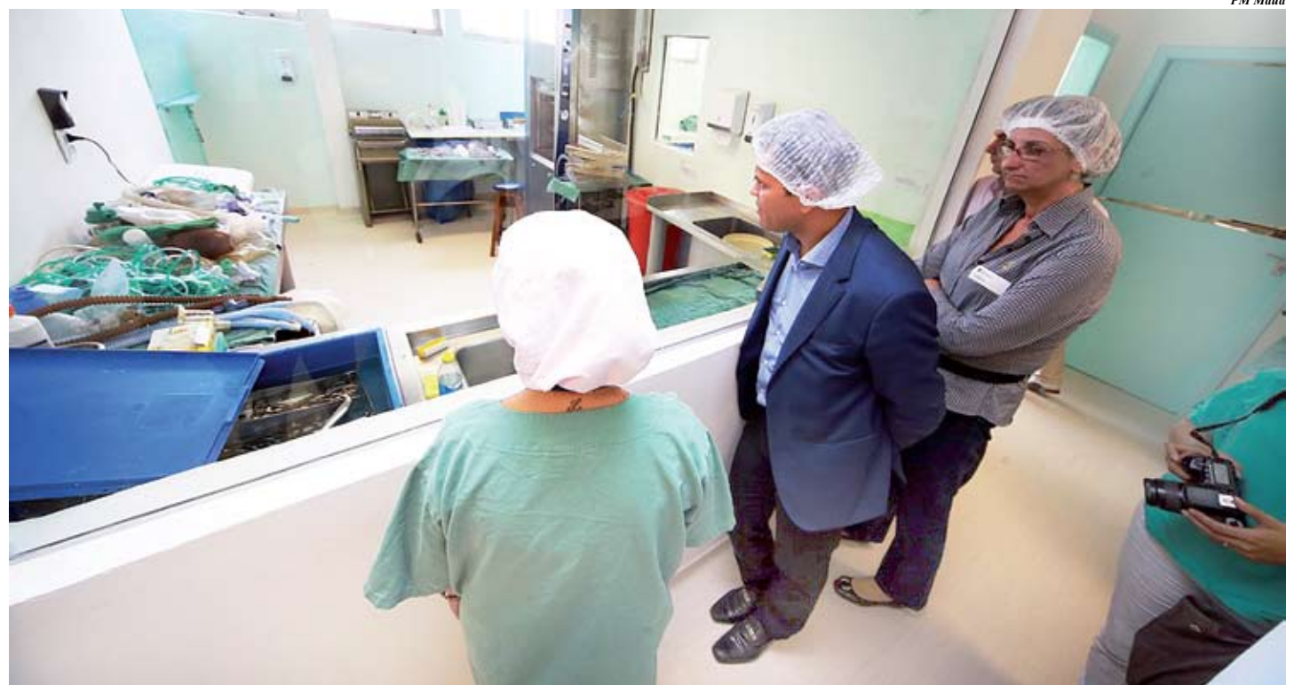
Com equipamentos novos e outros reformados, espaço é responsável pela lavagem e desinfecção de instrumental cirúrgico, materiais e roupa do centro cirúrgico
