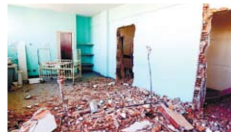
Obras para reforma da maternidade começaram em julho e devem durar até 12 meses
