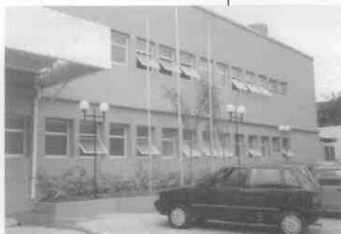
Fachada do Hospital Universitário
