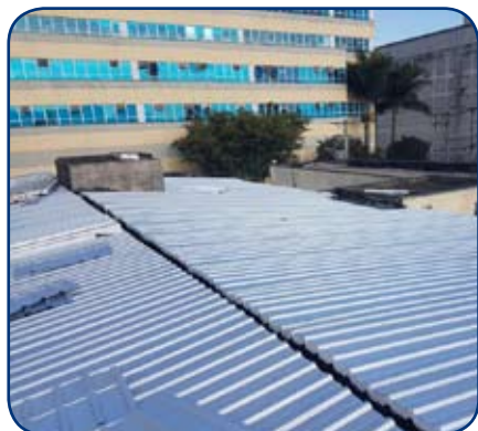
Novo telhado: ambulatório passou por reforma estrutural
