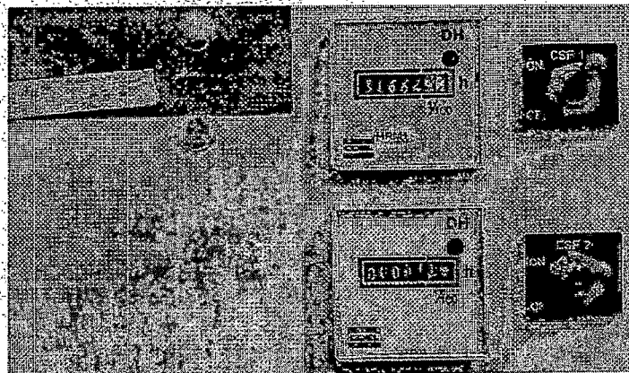
Novo horímetro instalado (posição 02).
