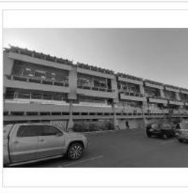
Área B ( VIDROS EXTERNOS 1° E 2° ANDAR )
