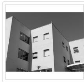
Área F ( JANELAS 3º ANDAR )
