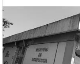
Área H ( CONCRETO E VIDROS EXTERNOS )
