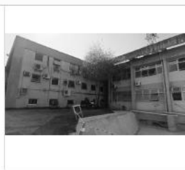
Área E ( CONCRETO/ VIDROS EXTERNOS/ TOLDO)
