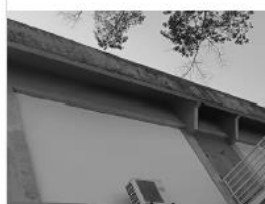
Área E ( CONCRETO/ VIDROS EXTERNOS/ TOLDO)
