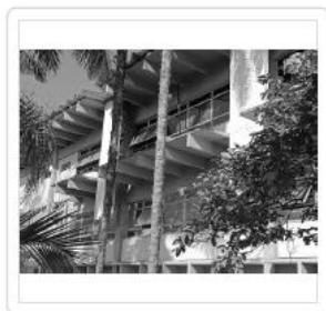
Área B ( VIDROS EXTERNOS 1° E 2° ANDAR )
