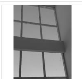
Área G (VIDROS INTERNOS FACHADA)
