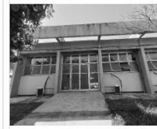
Área H ( CONCRETO E VIDROS EXTERNOS )
