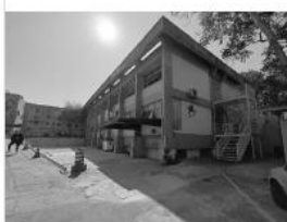
Área E ( CONCRETO/ VIDROS EXTERNOS/ TOLDO)
