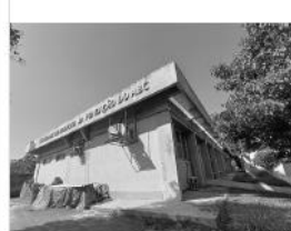
Área H ( CONCRETO E VIDROS EXTERNOS )
