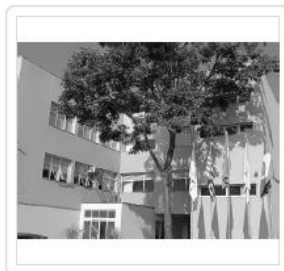
Área A ( VIDROS EXTERNOS 1° E 2° ANDAR )
