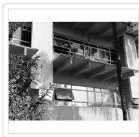
Área B ( VIDROS EXTERNOS 1° E 2° ANDAR )
