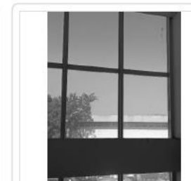
Área G (VIDROS INTERNOS FACHADA)
