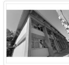
Área E ( CONCRETO/ VIDROS EXTERNOS/ TOLDO)
