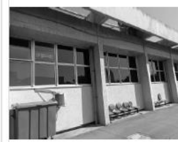
Área H ( CONCRETO E VIDROS EXTERNOS )
