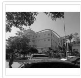
Área F ( JANELAS 3º ANDAR )
