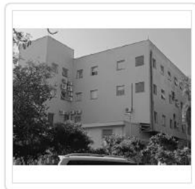
Área F ( JANELAS 3º ANDAR )
