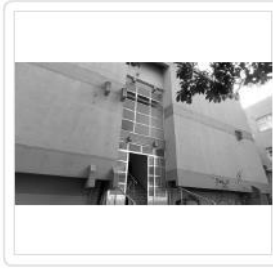
Área B ( VIDROS EXTERNOS 1° E 2° ANDAR )
