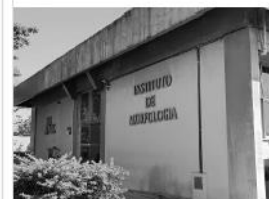
Área H ( CONCRETO E VIDROS EXTERNOS )
