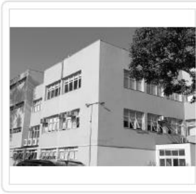
Área A ( VIDROS EXTERNOS 1° E 2° ANDAR )
