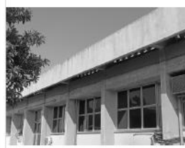
Área H ( CONCRETO E VIDROS EXTERNOS )
