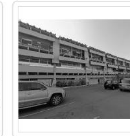
Área B ( VIDROS EXTERNOS 1° E 2° ANDAR )
