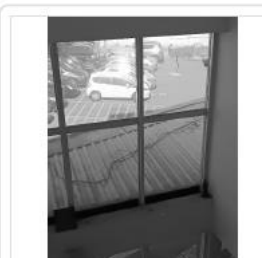
Área G (VIDROS INTERNOS FACHADA)
