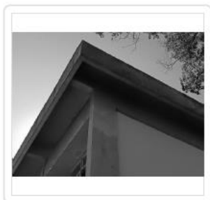
Área E ( CONCRETO/ VIDROS EXTERNOS/ TOLDO)
