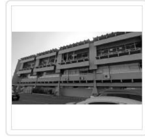
Área B ( VIDROS EXTERNOS 1° E 2° ANDAR )
