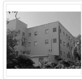
Área F ( JANELAS 3º ANDAR )
