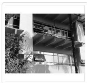
Área B ( VIDROS EXTERNOS 1° E 2° ANDAR )
