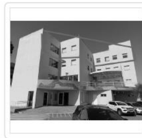
Área F ( JANELAS 3º ANDAR )
