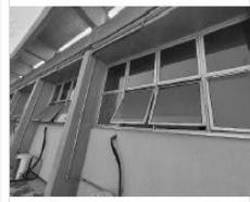
Área H ( CONCRETO E VIDROS EXTERNOS )
