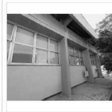
Área H ( CONCRETO E VIDROS EXTERNOS )
