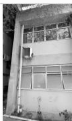
Área E ( CONCRETO/ VIDROS EXTERNOS/ TOLDO)
