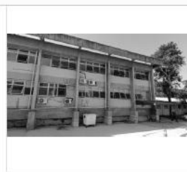
Área E ( CONCRETO/ VIDROS EXTERNOS/ TOLDO)
