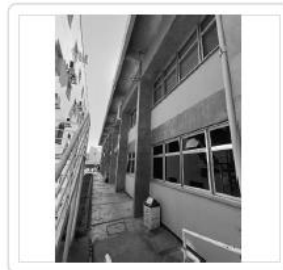
Área E PARTE TESOURINHA ( CONCRETO/ VIDROS EXTERNOS/ TOLDO)
