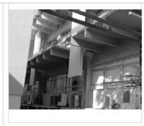
Área B ( VIDROS EXTERNOS 1° E 2° ANDAR )
