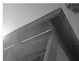
Área E ( CONCRETO/ VIDROS EXTERNOS/ TOLDO)
