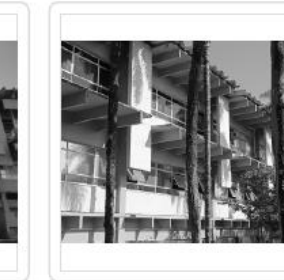
Área B ( VIDROS EXTERNOS 1° E 2° ANDAR )
