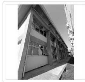
Área E ( CONCRETO/ VIDROS EXTERNOS/ TOLDO)
