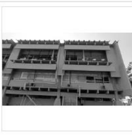
Área B ( VIDROS EXTERNOS 1° E 2° ANDAR )
