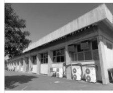
Área H ( CONCRETO E VIDROS EXTERNOS )
