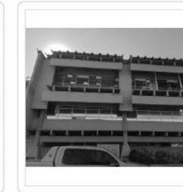
Área B ( VIDROS EXTERNOS 1° E 2° ANDAR )
