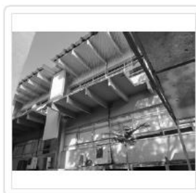
Área B ( VIDROS EXTERNOS 1° E 2° ANDAR )
