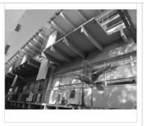
Área B ( VIDROS EXTERNOS 1° E 2° ANDAR )
