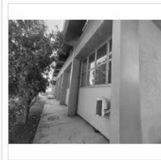
Área H ( CONCRETO E VIDROS EXTERNOS )
