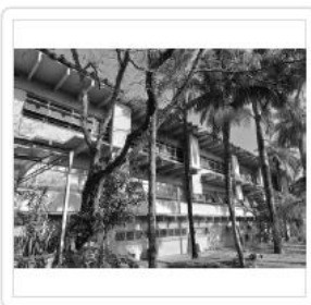
Área B ( VIDROS EXTERNOS 1° E 2° ANDAR )
