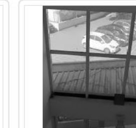
Área G (VIDROS INTERNOS FACHADA)
