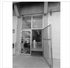
Área H ( CONCRETO E VIDROS EXTERNOS )
