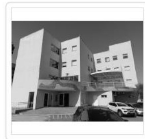
Área F ( JANELAS 3º ANDAR )
