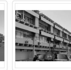
Área B ( VIDROS EXTERNOS 1° E 2° ANDAR )
