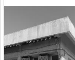
Área H ( CONCRETO E VIDROS EXTERNOS )
