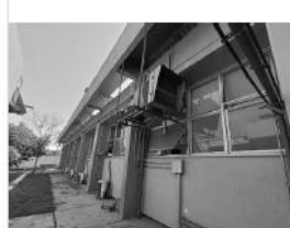
Área H ( CONCRETO E VIDROS EXTERNOS )
