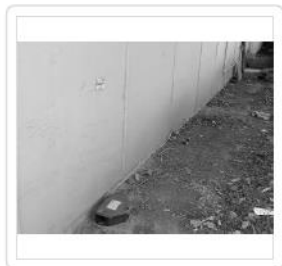
Área C ( PAREDE MADEIRA PINTADA ), Área D ( JANELAS)
