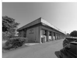
Área H ( CONCRETO E VIDROS EXTERNOS )
