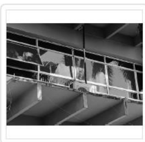
Área B ( VIDROS EXTERNOS 1° E 2° ANDAR )
