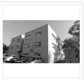
Área A ( VIDROS EXTERNOS 1° E 2° ANDAR )
