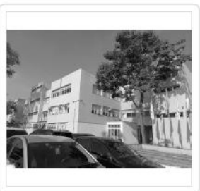
Área A ( VIDROS EXTERNOS 1° E 2° ANDAR )
