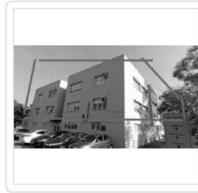
Área A ( VIDROS EXTERNOS 1° E 2° ANDAR )
