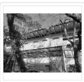
Área B ( VIDROS EXTERNOS 1° E 2° ANDAR )
