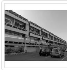
Área B ( VIDROS EXTERNOS 1° E 2° ANDAR )
