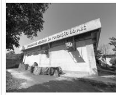
Área H ( CONCRETO )
