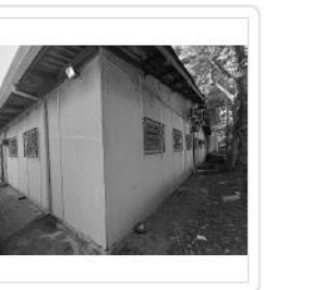
Área C ( PAREDE MADEIRA PINTADA ), Área D ( JANELAS)
