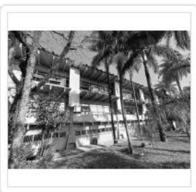
Área B ( VIDROS EXTERNOS 1° E 2° ANDAR )
