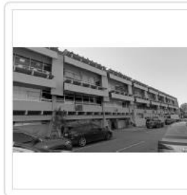
Área B ( VIDROS EXTERNOS 1° E 2° ANDAR )
