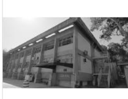
Área E ( CONCRETO/ VIDROS EXTERNOS/ TOLDO)
