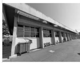
Área H ( CONCRETO E VIDROS EXTERNOS )
