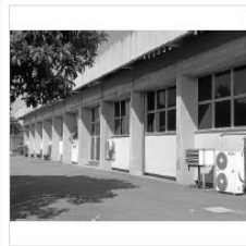
Área H ( CONCRETO E VIDROS EXTERNOS )
