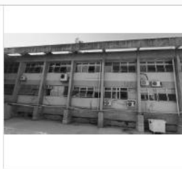
Área E ( CONCRETO/ VIDROS EXTERNOS/ TOLDO)
