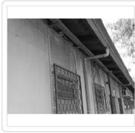
Área C ( PAREDE MADEIRA PINTADA ), Área D ( JANELAS)
