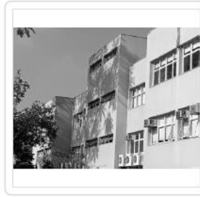
Área A ( VIDROS EXTERNOS 1° E 2° ANDAR )
