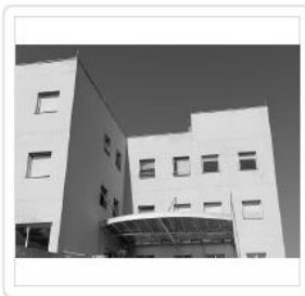
Área F ( JANELAS 3º ANDAR )
