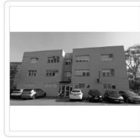
Área A ( VIDROS EXTERNOS 1° E 2° ANDAR )
