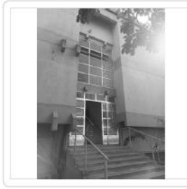
Área B ( VIDROS EXTERNOS 1° E 2° ANDAR )
