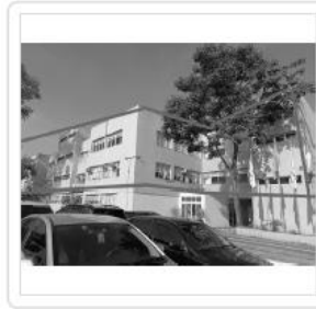
Área A ( VIDROS EXTERNOS 1° E 2° ANDAR )
