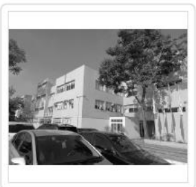
Área A ( VIDROS EXTERNOS 1° E 2° ANDAR )
