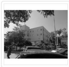
Área F ( JANELAS 3º ANDAR )
