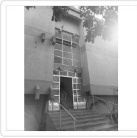
Área B ( VIDROS EXTERNOS 1° E 2° ANDAR )
