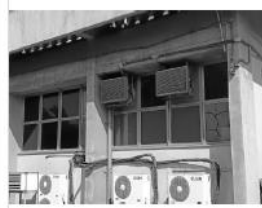
Área H ( CONCRETO E VIDROS EXTERNOS )
