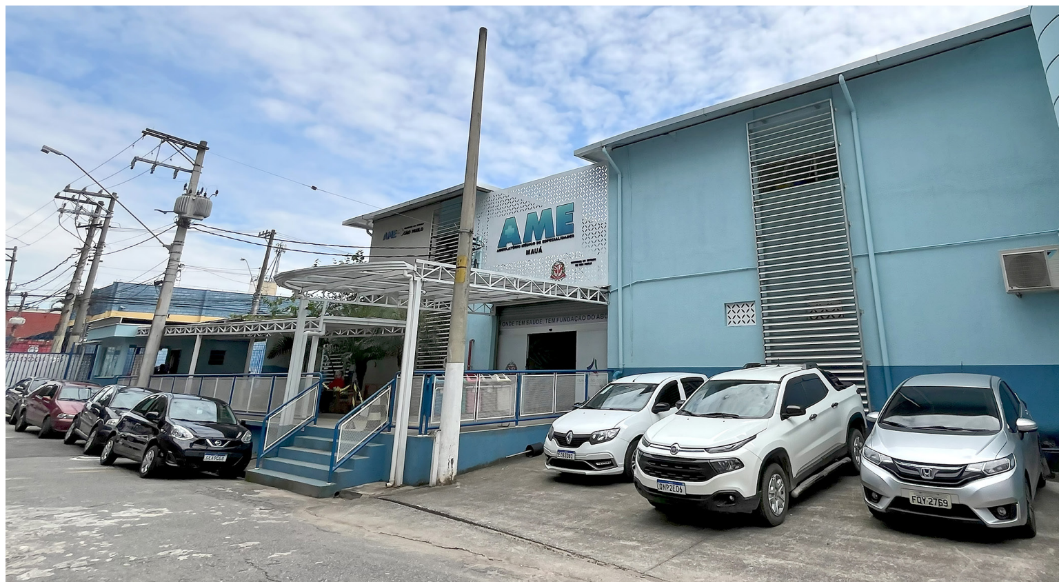
Unidade recebeu nova fachada, pintura externa e interna, piso vinílico, sinalização, entre outros reparos
