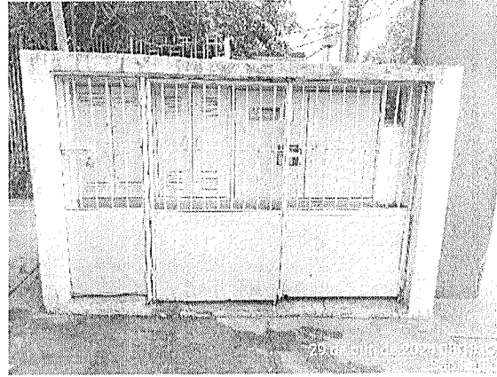
Figura 5. Padrão instalado em outra unidade.
