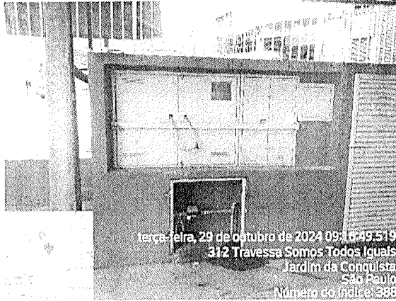
Figuras 05 e 06. Abrigo de entrada de energia elétrica.
