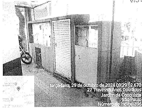
Figuras 05 e 06. Abrigo de entrada de energia elétrica.
