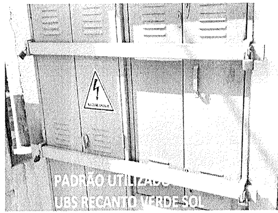
Figuras 07 e 08. Modelo de gradil a ser instalado e modelo de barra de proteção a ser instalada sobre o gradil.
