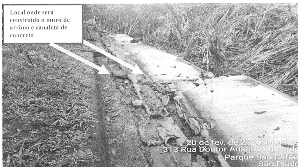
Fig. 1- Local onde será feita alvenaria de contenção
