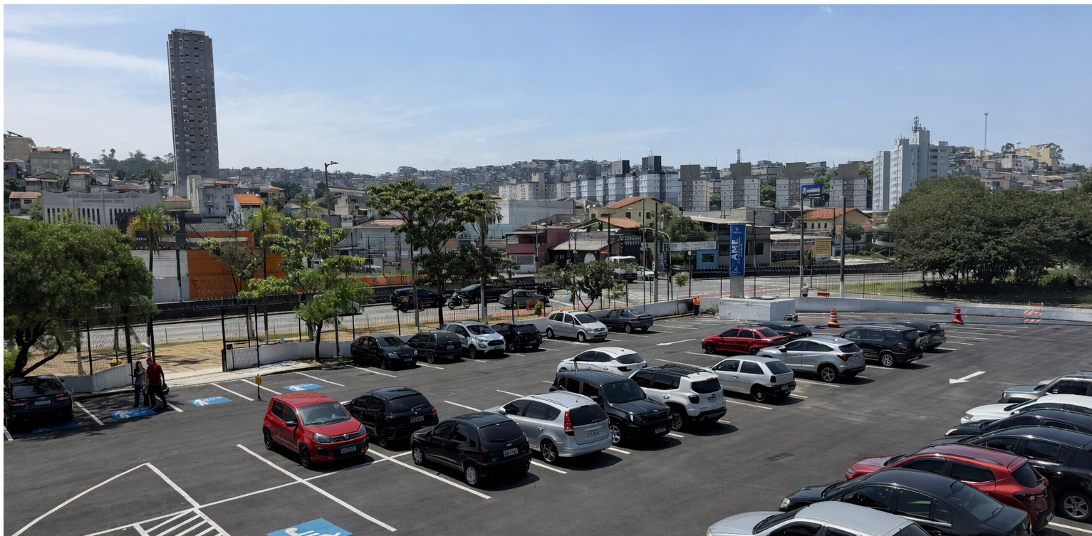
Foram construídos canais de captação e drenagem do pátio de estacionamento da unidade
