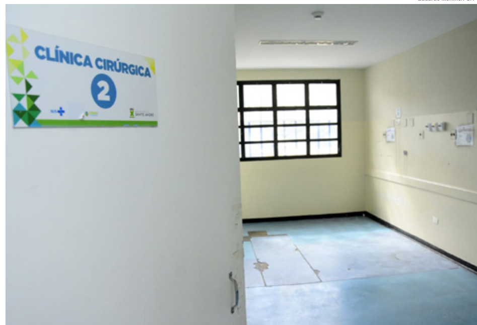
Espaço receberá melhorias estruturais e novo mobiliário
