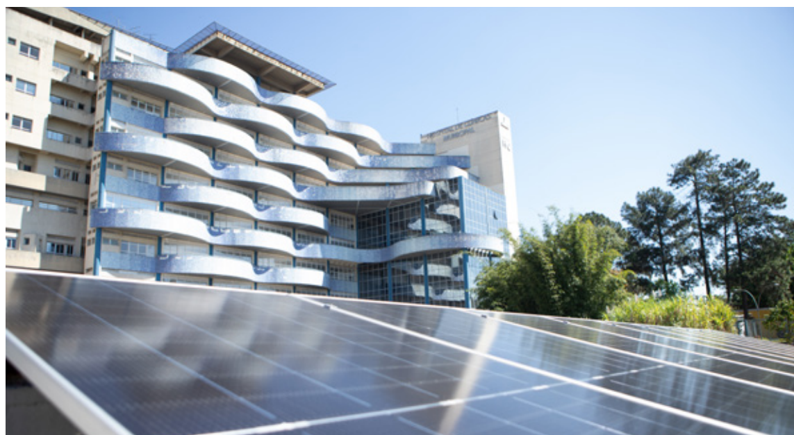
Instalação das placas foi finalizada na segunda metade de agosto
